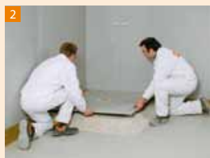
Wariant 1a: ściągnąć podsypkę wiązaną do wysokości górnej krawędzi kratki ściekowej w obszarze elementu odpływowej kabiny natryskowej i osadzić element
