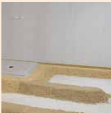
Odczekać ok. 20 minut aż nasypy naciągną
