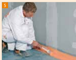
5 Taśmę uszczelniającą pokryć płynną folią bezpośrednio po wciśnięciu jej.
