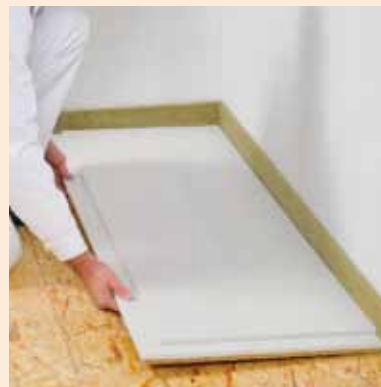
Układanie elementów jastrychowych FERMACELL
