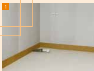
Po zaznaczeniu położenia elementu odpływowej kabiny natryskowej, osadzić kratkę
