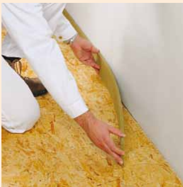
Taśmy do izolacji krawędzi – umieścić w narożach na styk
