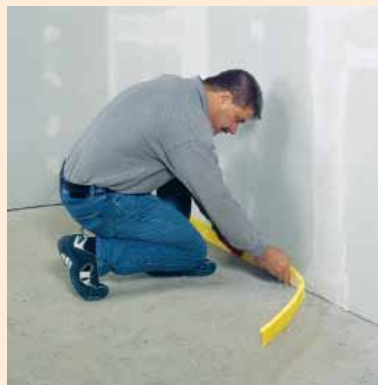
Naniesienie taśmy izolacyjnej do krawędzi
