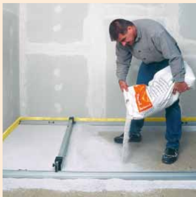
Wysypać podsypkę wyrównującą FER-MACELL
