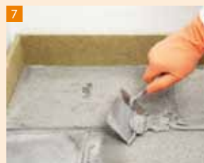
Nadmiar kleju jest zbierany kielnią i użyty w dalszej pracy
