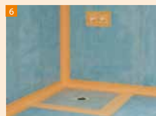
Ułożone elementy podłogowe Powerpanel TE, po sklejeniu i umocowaniu wkrętami, należy zagruntować i uszczelnić w obszarach łączeń systemem uszczelniającym
