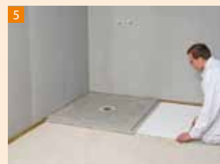
Wariant 1b: na wysokości zakładki elementu odpływowego ułożyć na powierzchni materiał izolacyjny o grubości 10 mm (EPS DEO 150)
