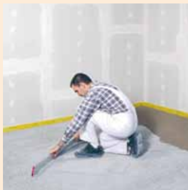
Ściągnąć kruszywo wypełniające „plastry miodu” FERMACELL
