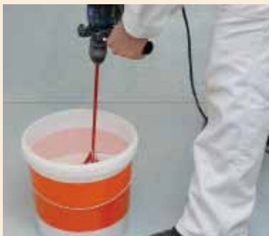
Mieszać za pomocą mieszalnika na niskich obrotach, aż do uzyskania homogennej, jednolitej masy poziomującej
