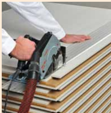
Odciąć wystającą zakładkę dla ułożenia pierwszego rzędu
