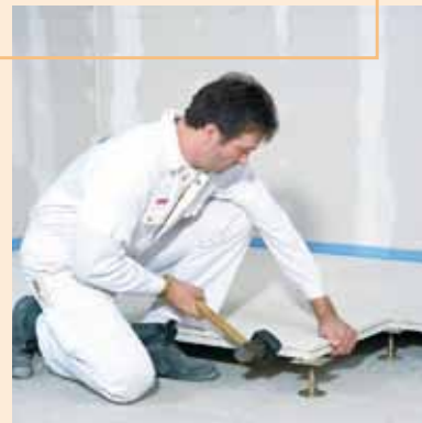
Łączenie, dopasowywanie elementów podniesionej podłogi FERMACELL
