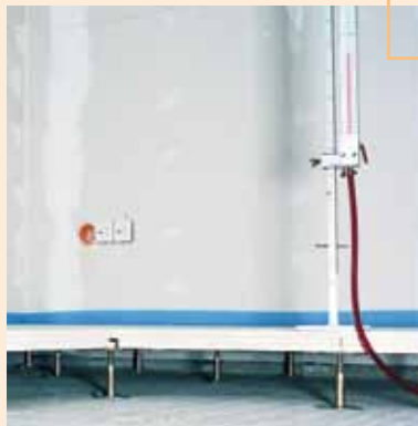
Poziomowanie podniesionej podłogi przy pomocy wodnej wagi
