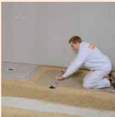
Po usypaniu podsypki pomiędzy dwa nasypy, zgarnąć podsypkę łatą wyrównawczą
