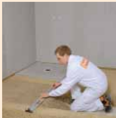
Po usypaniu podsypki pomiędzy dwa nasypy, zgarnąć podsypkę łatą wyrównawczą
