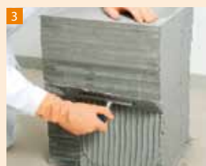
Klej rozprowadzamy za pomocą szpachli o odpowiednim uzębieniu (6 do 8 mm) po dwóch stronach stosu płyt
