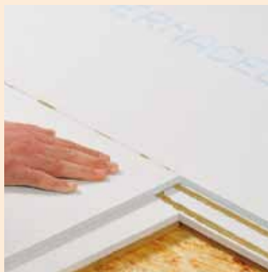
Sklejenie elementów jastrychowych ze spoiną w pełni wypetnioną
