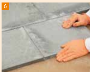
Płyty zostają szczelnie dosunięte do siebie (szerokość spoiny ok. 1-1,5 mm)
