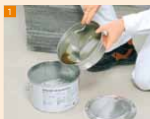
Obydwa komponenty kleju całkowicie łączą się ...
