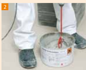
...i zostają wymieszane mieszadłem do uzyskania homogennej konsystencji
