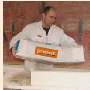
Zawartość całego worka wymieszać w mieszalniku do wytwarzania masy betonowej
