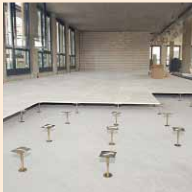
Podłoga podniesiona w suchej technologii ze stopkami nośnymi FERMACELL
