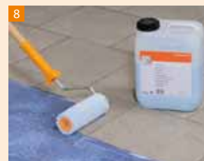
Kiedy powierzchnia nadaje się do chodzenia, należy wykonać ciepłopowierzchniowe gruntowanie odpowiednie dla systemu.
