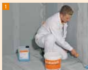
1 Grunt FERMACELL nanieść w obszarze stykania się ściany ...
