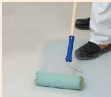
Przygotowanie: zagruntować podłoże
