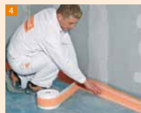
4 Wcisnąć taśmę uszczelniającą na mokrą powłokę z płynnej folii FERMACELL
