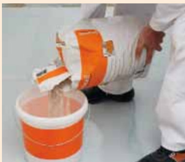
W czystym pojemniku wymieszać zawartość worka z wodą w ilości 6.5 litra
