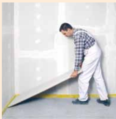
Ułożyć elementy jastrychowe FERMACELL
