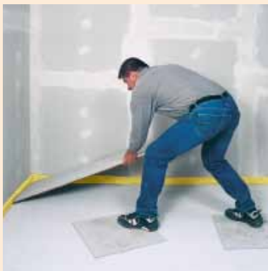
Układanie elementów jastrychowych FER-MACELL na podsypce wyrównującej
