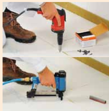
Łączenie w ciągu 10 minut poprzez skręcanie wkrętami ... ... lub specjalnymi klamrami rozprężnymi
