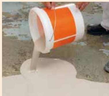
Wylać masę poziomującą i wyrównać
