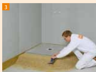
Wariant 1a: naokoło elementu odpływowego usypać nasyp o szerokości ok. 200 mm i ściągnąć nadmiar na wysokość zakładki
