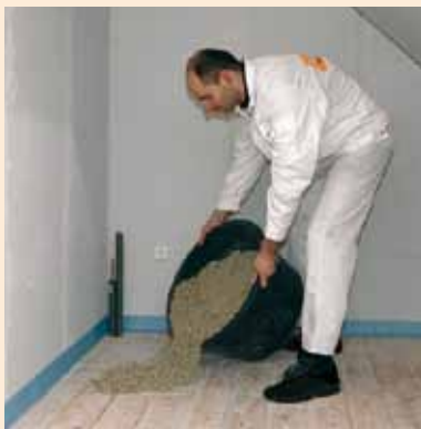
Podsypka wiązana uzyskuje konsystencję wilgotnej ziemi
