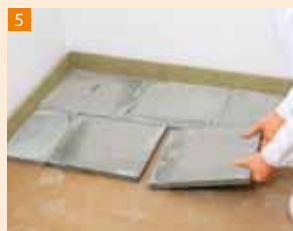
Powerpanel SE jest układany systemem ciągłym, tak że nie powstają żadne odpady
