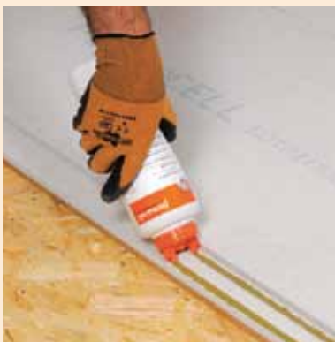
Naniesienie kleju do jastrychów FERMACELL na zakładki
