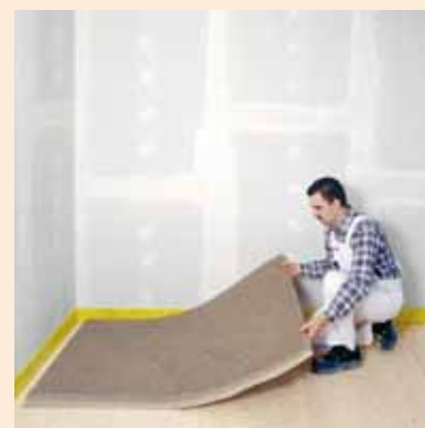
Nakładanie maty tekturowej „plaster miodu” FERMACELL
