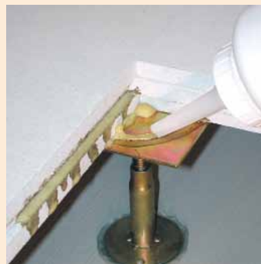
FERMACELL klej do jastrychów nanieść na kwadratową płytkę stopki nośnej
