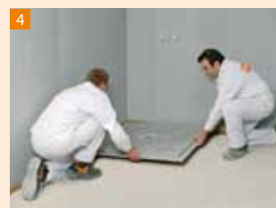
Wariant 1b: ściągnąć podsypkę wiązaną na całej powierzchni kabiny do wysokości górnej krawędzi kratki i osadzić element odpływowy kabiny natryskowej
