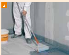
2 ... i podłoża za pomocą wataki
