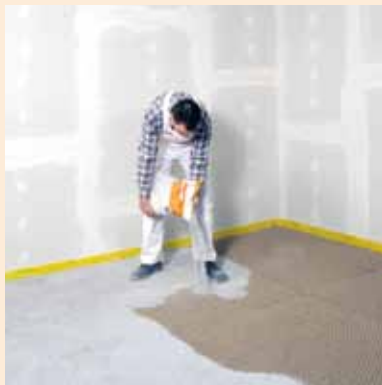
Wysypać kruszywo wypełniające „plastry miodu” FERMACELL
