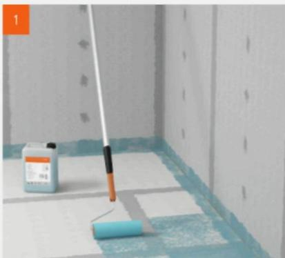
1 Środek głęboko gruntujący fermacell™ nanosić w sąsiedniej strefie ściany i podłogi wałkiem.
