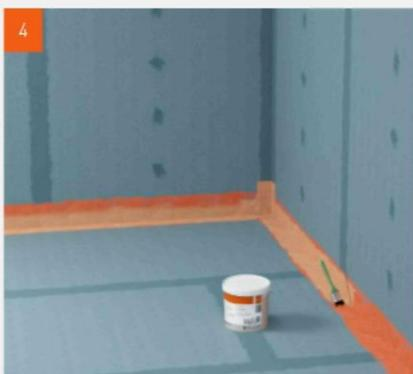
4 Bezpośrednio po wciśnięciu fermacell™ taśmy uszczelniającej w narożach należy ją zakryć kolejną warstwą fermacell™ płynnej folii
