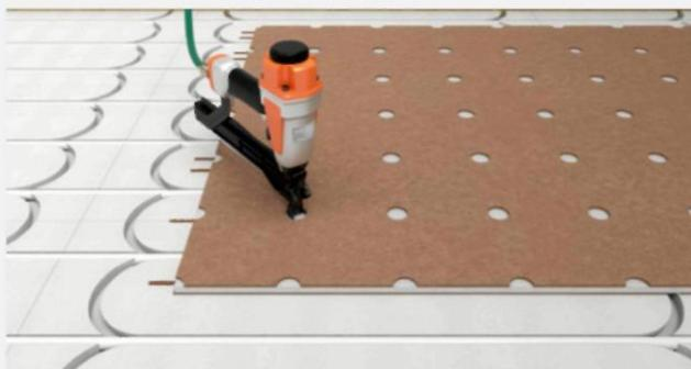
Montaż mechaniczny z użyciem wkrętów lub zszywek za wykorzystaniem szablonu montażowego fermacell® Therm25™-167.
