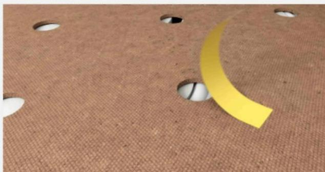
Przyłożenie szablonu w planowanej strefie montażu zakrywającej płyty gipsowo-włóknowej fermacell®.
