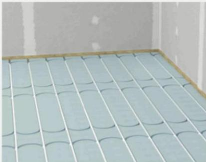
Montaż rur ogrzewania podłogowego 16 mm
