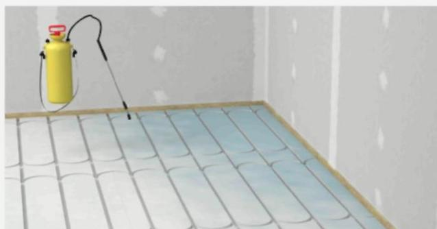
Gruntowanie elementów fermacell® Therm25™ przy użyciu Środka głęboko penetrującego fermacell™.
