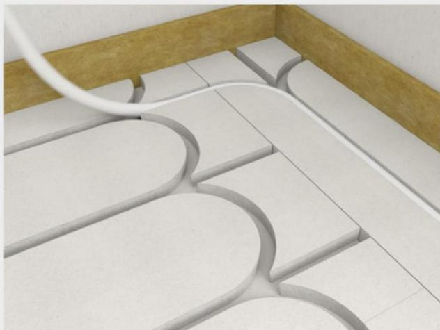
Montaż rur grzewczych 16 mm, specjalne wpusty nie wymagają dodatkowej obróbki pod instalację. Dzięki indywidualnemu cięciu elementów fermacell® Therm25™ można zrealizować wiele różnych sytuacji prowadzenia rur bez wykorzystania elementu fermacell® Therm25™ okrągły.
