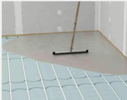
Zakrywanie elementów fermacell® Therm25™ przy użyciu Kleju gipsowego fermacell™
