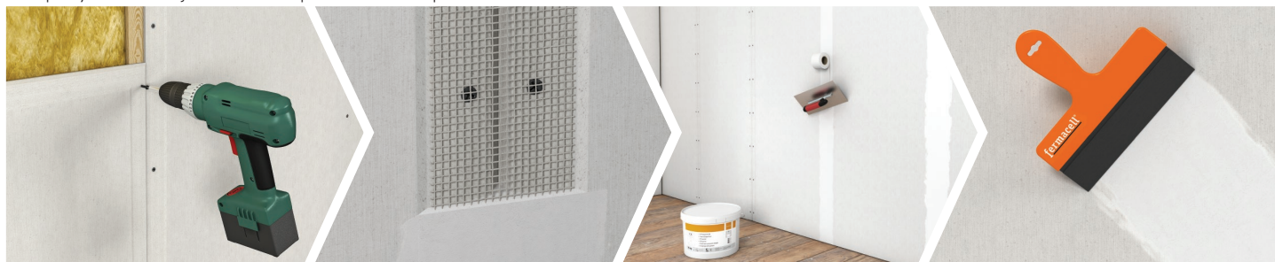
Mocowanie wkrętami lub klamrami-zszywkami
